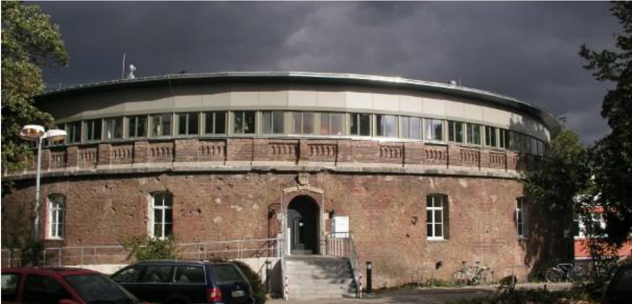
Außenansicht des Reduit mit Freitreppe; Oktober 2004
